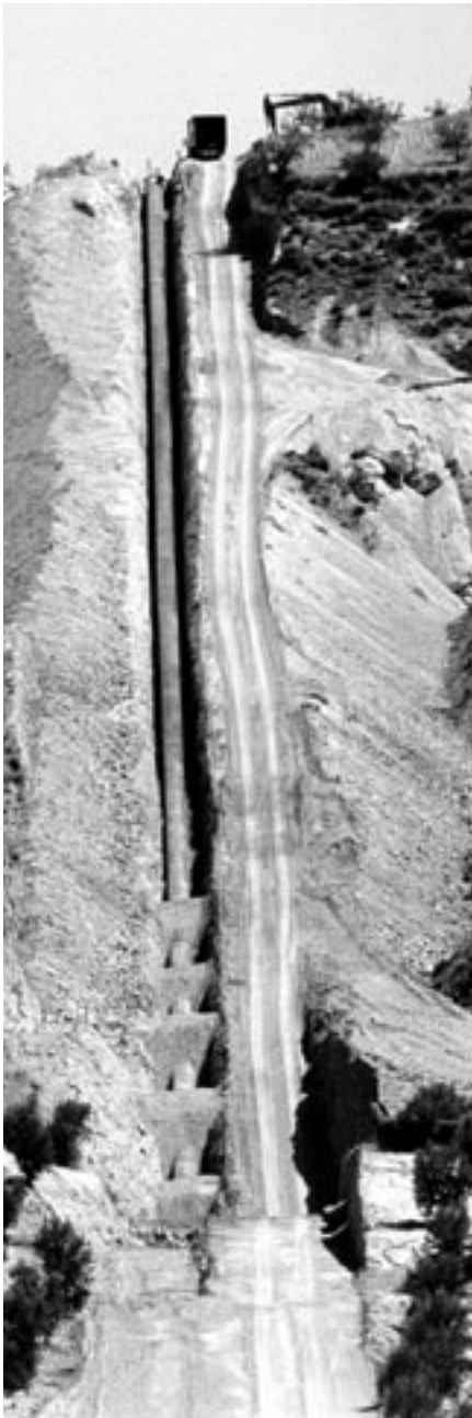
Obras de instalación de la tubería del trasvase del Negratín.
