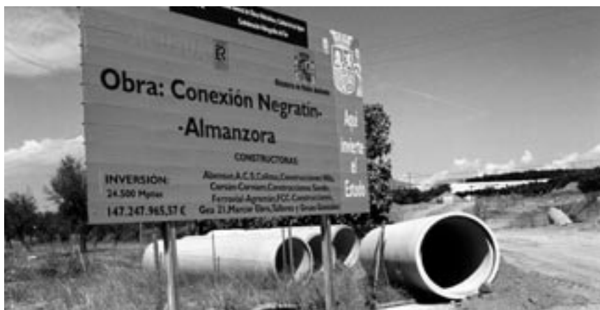
Cartel del Ministerio de Medio Ambiente anunciando las obras del trasvase del Negratín.
